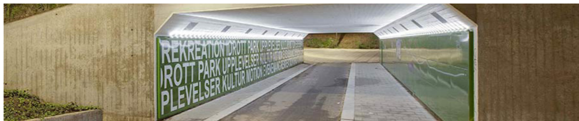
Tunnel i Helsingborg med beklädnad av kassetter i emalj som underlättar klottersanering. Bild av: Helsingborgs stad
