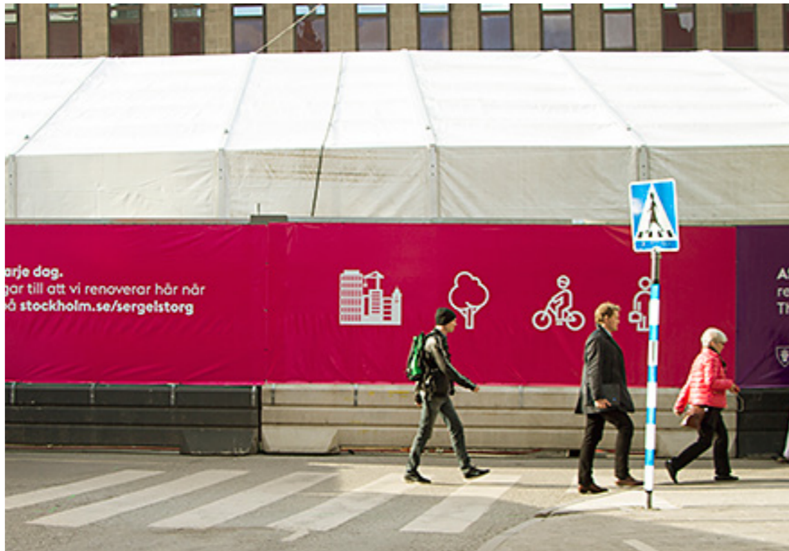
Informationsskyltar vid ombyggnation Bild av: Stockholms stad
