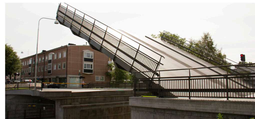
Västra Kanalbron har en frihöjd på 3,25 när den är stängd och det förväntas av nya Nybron med
